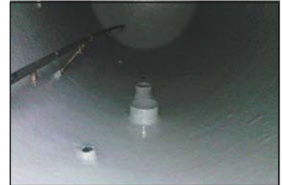
Superficie interna del tanque recubierta.
